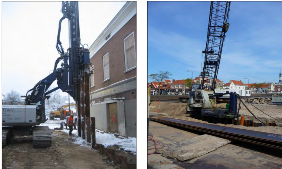
Fig. 3-4: De damwanden worden aangebracht door deze in de grond te drukken
