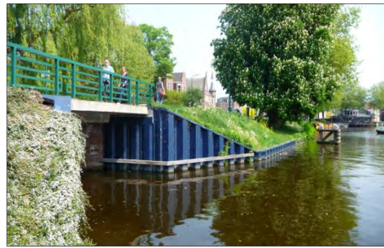
Fig 2-5: Impressie beklede kadewand, metselwerk en dekzerk (links) en de onbektele damwand nabij de Westdambrug
